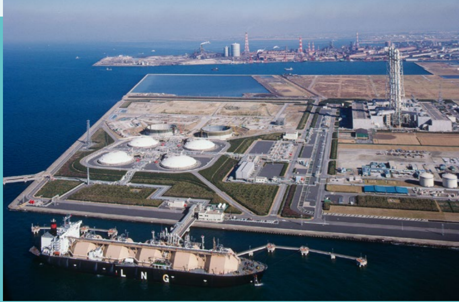
Tanker at LNG terminal. © MsLightBox / Getty Images
