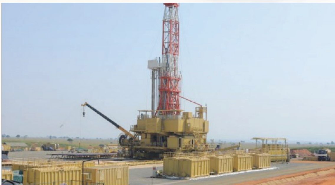
La tour de forage du projet pétrolier Tilenga dans le PNMF Crédit photo : The Independent
